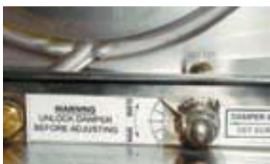
Giljotin- eller BT-spjäll styr spjällägesindikatorn och inställningsskruven.
